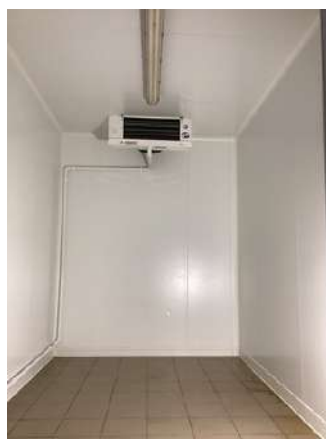
14. Ensemble chambres froides et locaux techniques en panneaux sandwich
