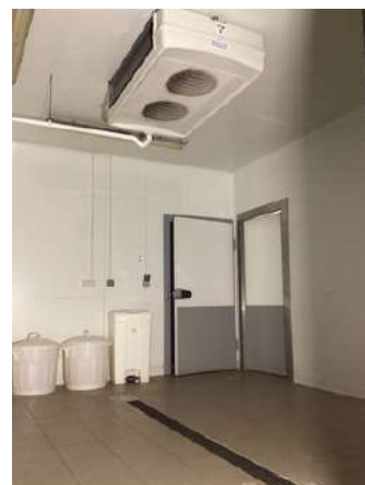
14. Ensemble chambres froides et locaux techniques en panneaux sandwich
